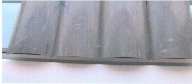
Fig. V.1 Outer pipe wall.
